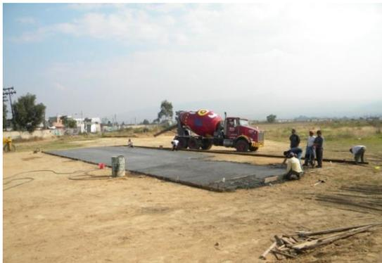
Figura No. 37 Construcción de plancha para construcción de aulas prefabricadas año 2009
