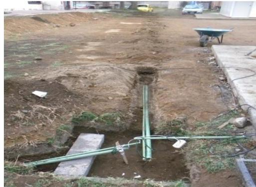
Figura No. 74 Instalación de red eléctrica para aulas prefabricadas
