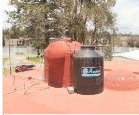
Figura No. 77 Instalación de tinaco en construcción existente
