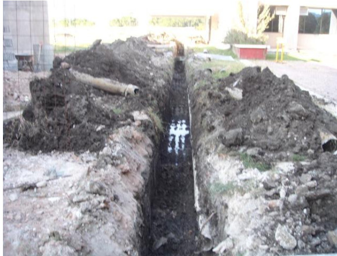
Figura 5. Obra de adecuación de la fosa séptica y descarga de aguas grises.
