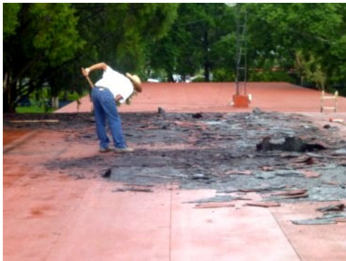
Impermeabilización del Edificio "K" y Edificio "O", con material prefabricado.
