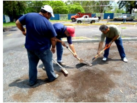
Balizamiento y bacheo en los estacionamientos de la institución.
