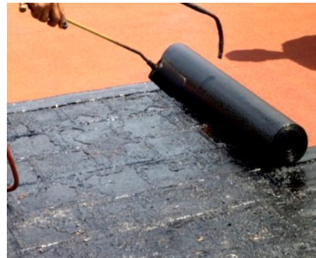
Impermeabilización del Edificio "K" y Edificio "O", con material prefabricado.
