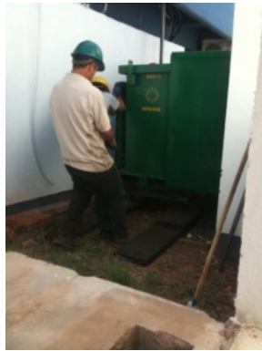
Mantenimiento al transformador de 150 kva que se encuentra a un costado de la plaza del estudiante.
