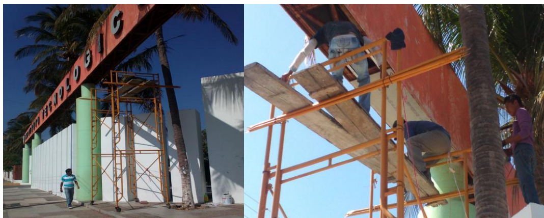
Mantenimiento de la fachada principal
