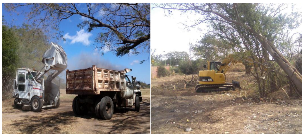
Limpieza y acondicionamiento de acceso a canchas deportivas
