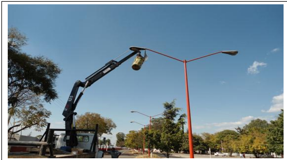
Rehabilitación luminarias del Sistema Eléctrico del estacionamiento del Instituto.
