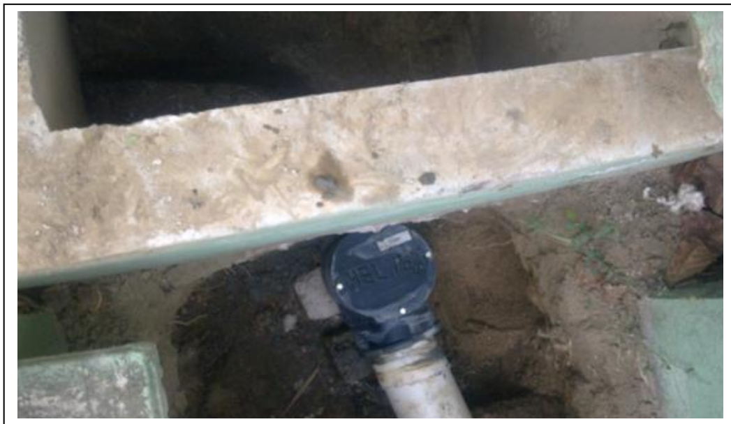
Suministro y colocación de válvula compuerta en el Claustro Doctoral.
