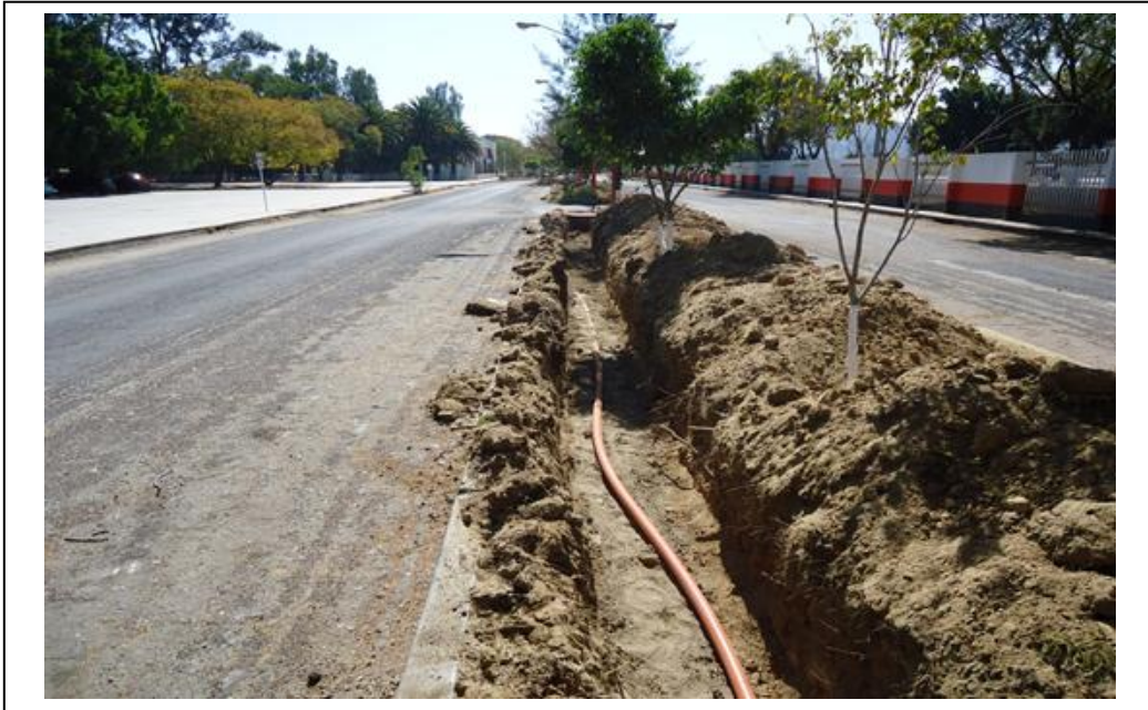
Inicio trabajos mantenimiento del Sistema Eléctrico del estacionamiento del Instituto.
