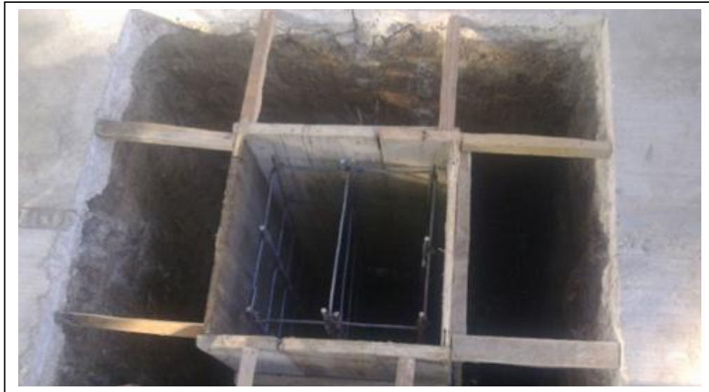
Preparación para colocación de válvula compuerta en el Claustro Doctoral.
