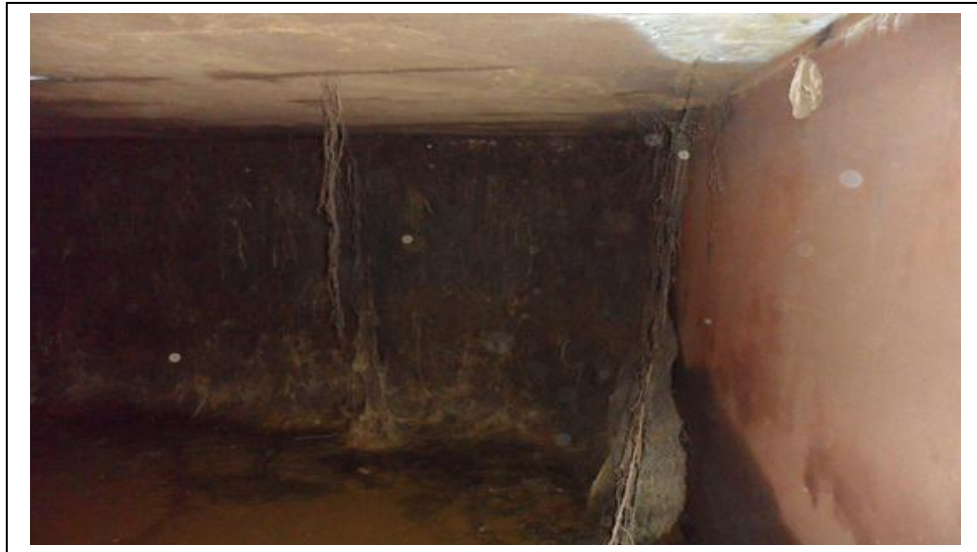
Raíces y fisuras de la cisterna general que provocaban filtración.
