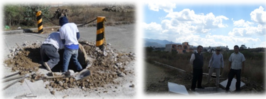
Imagen 27 conexión del drenaje a la red municipal
