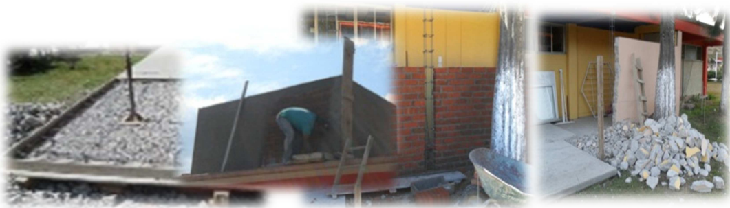
Imagen 24. Reparación y construcción de infraestructura
