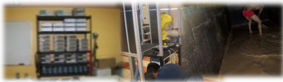
Imagen 25. Revisión del sistema eléctrico y mantenimiento a cisterna
