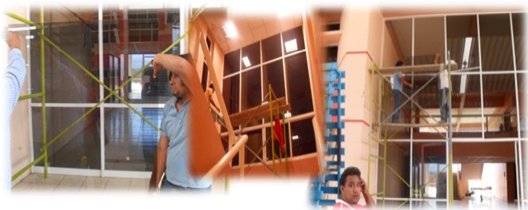
Imagen 21. Colocación de cristal templado y película de seguridad a edificios.
