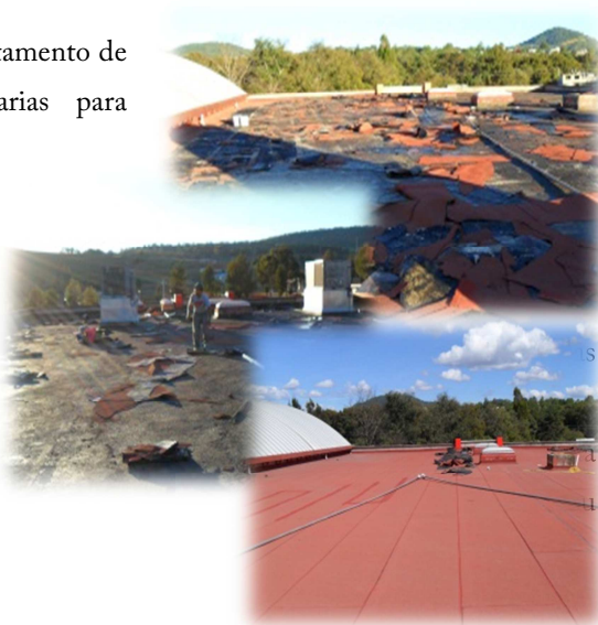
Imagen 20. Cambio de impermeabilizante del edificio académico departamental en 2012
