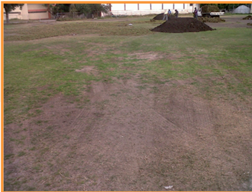
Rehabilitación del campo de Futbol Soccer
