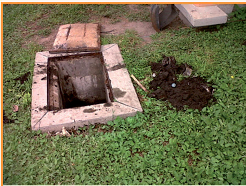
Mantenimiento a los registros de aguas negras
