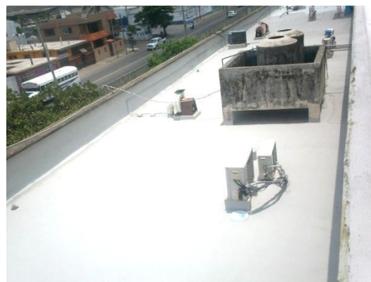
Figura 36. Mantenimiento a la impermeabilización del edificio de UNIDA.
