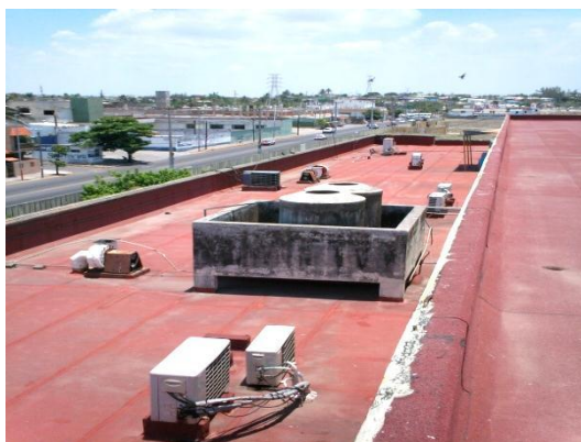
Figura 36. Mantenimiento a la impermeabilización del edificio de UNIDA.
