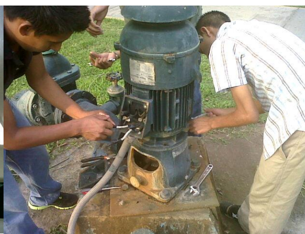
Figura 38. Cambio de luminarias y mantenimiento a la bomba del pozo profundo.
