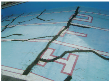
Reparación de Alberca
