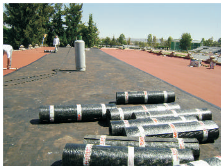
Impermeabilización de Edificios
