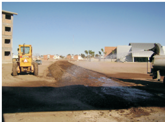
Arreglo de acceso a Zona Norte (Riego de Impregnación)
