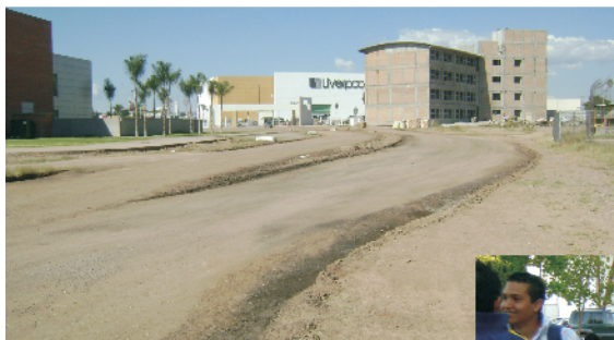
Construcción de vialidad en Zona Norte
