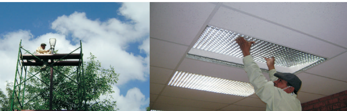
Personal de electricidad realizando cambios de luminarias.
