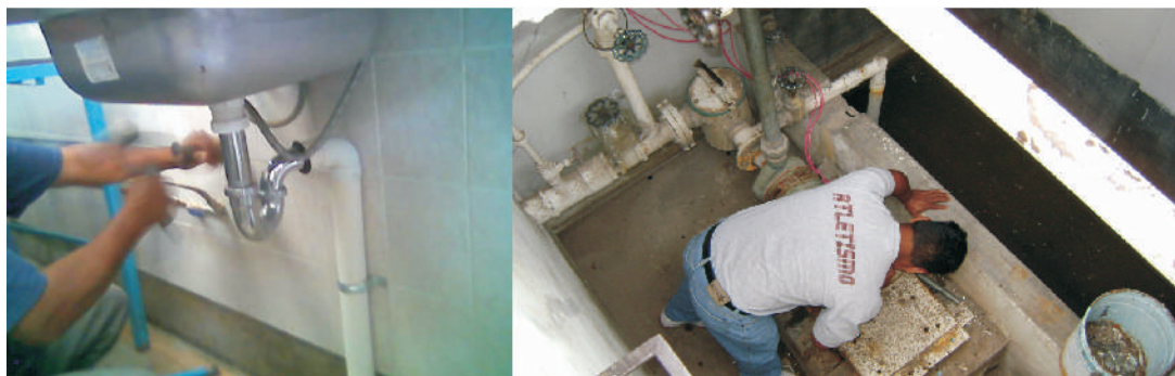
Personal de plomería realizando trabajos de mantenimiento preventivo y correctivo.
