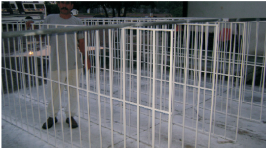
Personal de Soldadura elaborando protecciones para salones
