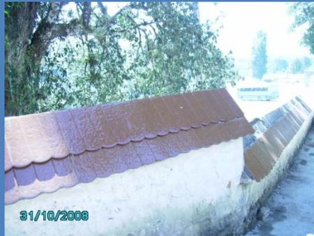
Colocación de teja en dintel del la barda perimetral
