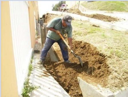
Rebocado de terraplén de canal de descarga Pluvial
