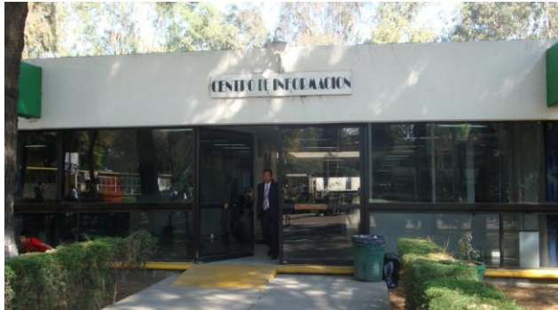
Unidad Administrativa Edificio "B"
