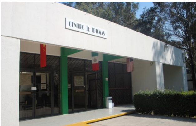
Unidad Administrativa Edificio "C"
