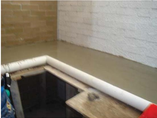
El 14 de Septiembre se realizaron trabajos de mejora con la construcción de una repisa de concreto para la instalación del Espectro de Absorción Atómica, equipo del área de investigación, y del emboquillado de marco de la entrada al Laboratorio de Investigación de Síntesis Orgánica, en cumplimiento de los requerimientos del CACEI en el punto 6.3.- Características de los laboratorios.
