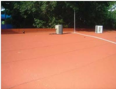
El 24 de Marzo se retiró el impermeabilizante deteriorado del edificio "H" del laboratorio de Química de Ingeniería Bioquímica y se aplicó una nueva capa de 3.5 mm de espesor con esfuerzo central de fibra de vidrio de 90 gramos y gravilla en color rojo en un área de 462.56 m<sup>2</sup>.
