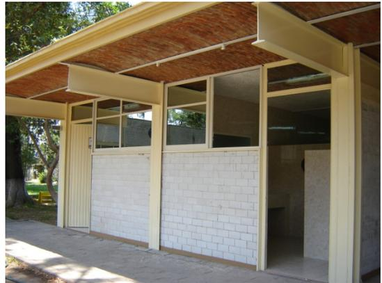
***Cristalería en vidrio filtrasol oscuro en aulas afectadas directamente por el sol.***
