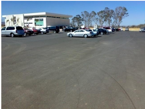
Unidad Académica Departamental tipo II y estacionamiento del Instituto Tecnológico de Pabellón de Arteaga
