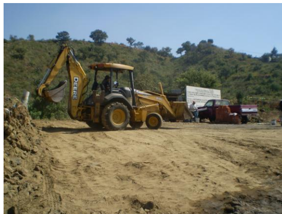
Maquinaria trabajando en el predio
