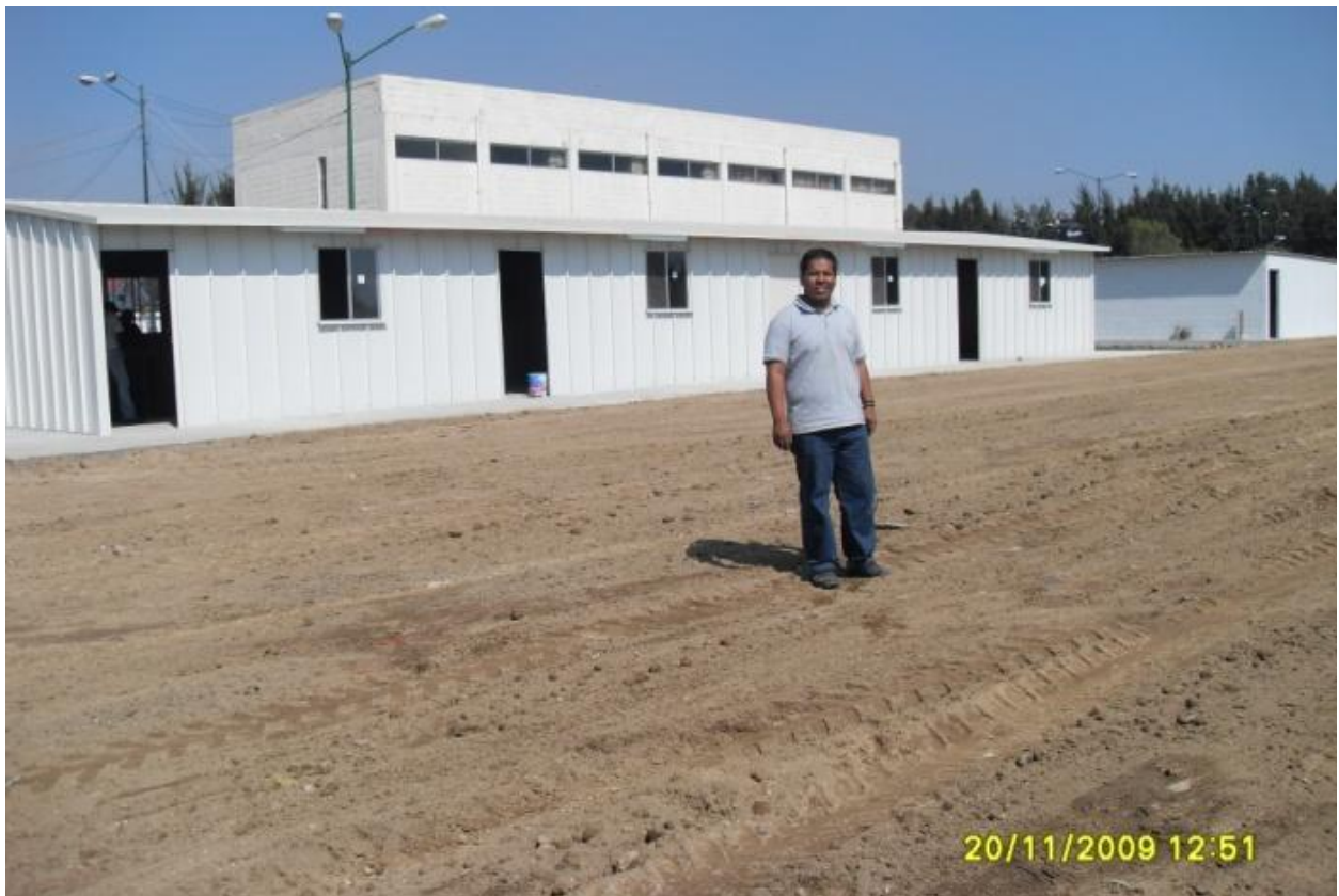
Nivelación y compactación de espacios libres.
