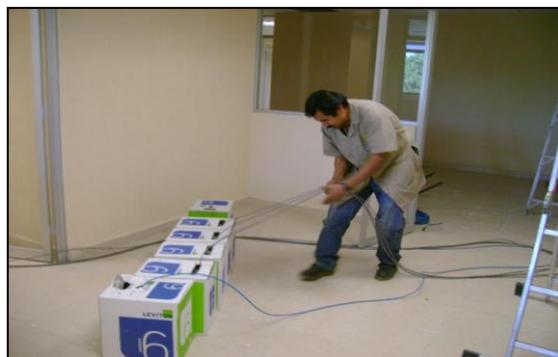
Instalación de fibra óptica CIIDET
