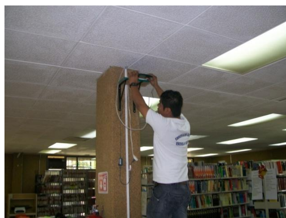
Figura 7. Instalación del router en el C.I.
