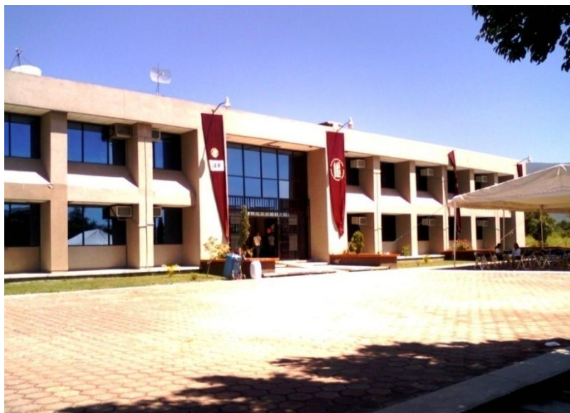
Figura 1. Edificio "F" Académico-Departamental.
