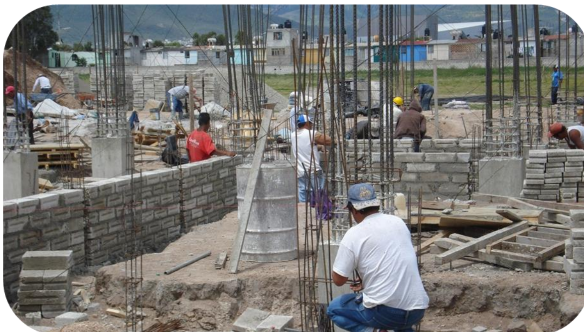
Construcción de la Unidad Académica
