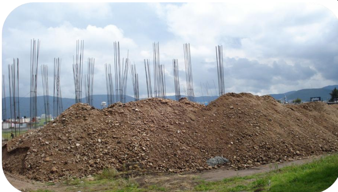
Construcción de la Unidad Académica
