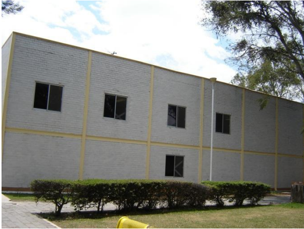
Impermeabilización y pintura exterior del edificio de Ingeniería Mecánica
