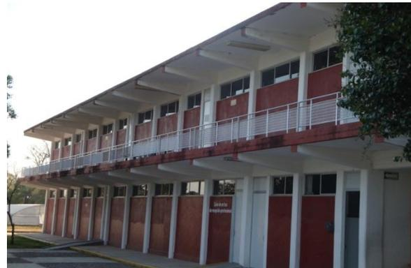
Figura 30. Cambio de barandales de los edificios C, D y J.
