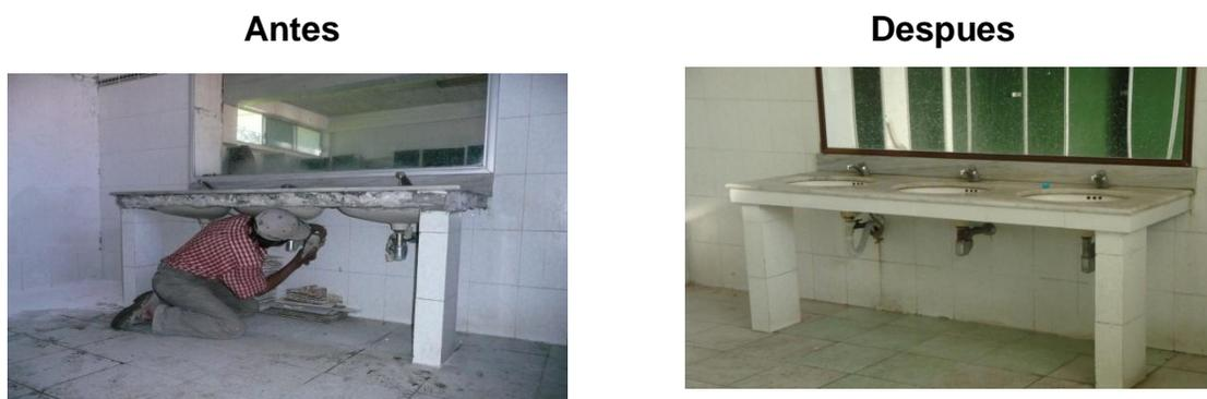
Figura 28. Reparación de lavabos de los edificios C y D.
