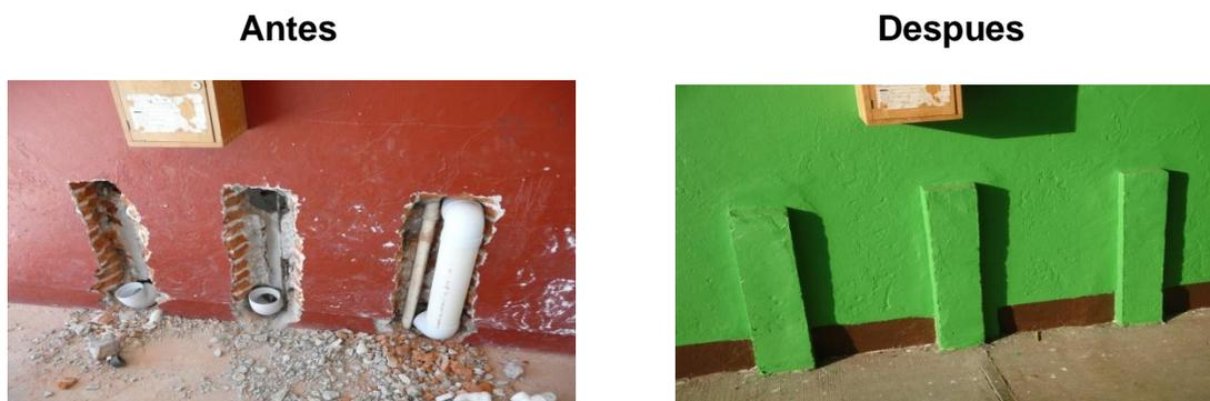
Figura 27. Cambio de tuberías de sanitarios de los edificios C y D.
