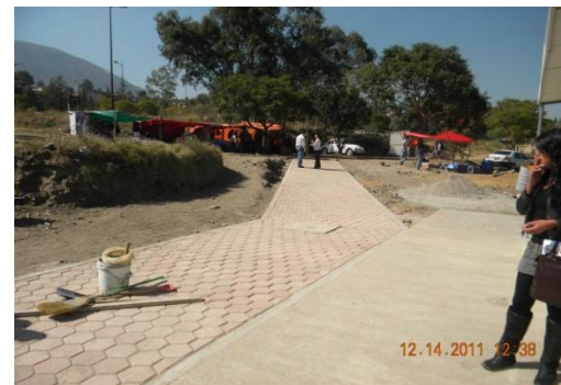
Colocación del Adoquín.
