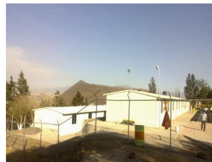
Vista de la barda y 2 Módulos.
