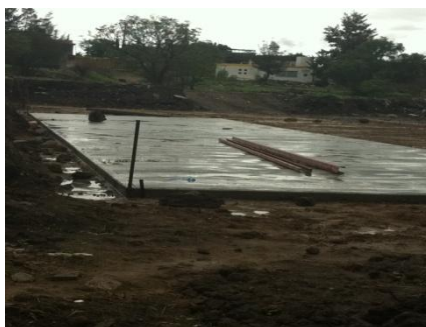
Colocación de la Primera plancha de Concreto.
