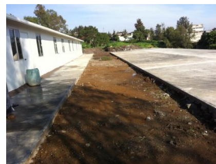
Armado de la Segunda Plancha de Concreto.
