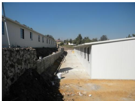
Instalación de Muro de Contención.
