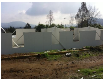
Armado de las aulas Prefabricadas.
