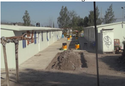
Entrada digna en Proceso de Construcción.
