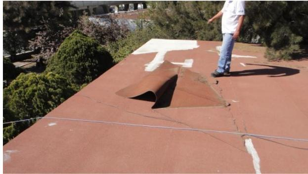
Impermeabilización del edificio en grietas y partes dañadas
