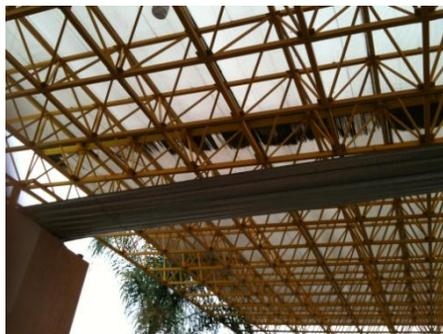
Retiro del policarbonato y colocación de lamina pintro.
