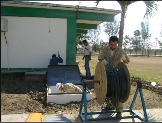
Fig.7 I.T. Altamira. Instalación de fibra óptica
