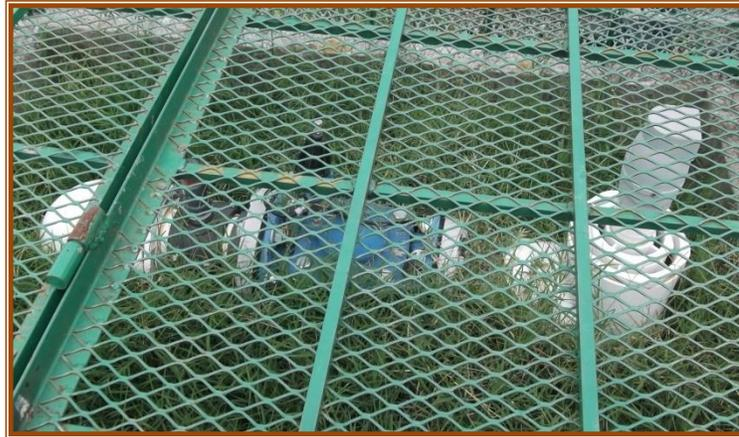
Foto No. 5.2 Protecciones de Herrería a Válvulas del Sistema de Riego de la Recibidora.
