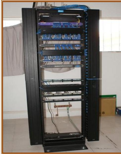
Foto 3.26 Rack con Cableado Estructurado y Fibra Óptica de Postgrado.
