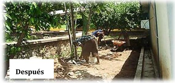
**Mantenimiento a canal y rejillas del edificio de la sala de maestros.-** Llevado a cabo, con la finalidad de evitar daños a los espacios físicos del edificio por inundación y encharcamiento debido al desbordamiento del agua pluvial. Monto de la inversión \$30,835.57
