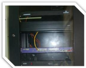
Se instaló un gabinete para equipo de telecomunicaciones y nuevo concentrado para acceso inalámbrico para el acceso a internet. Equipo configurable para acceso a internet inalámbrico para los estudiantes.
