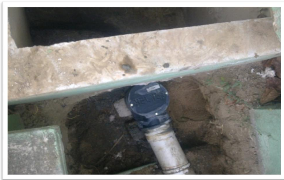
Imagen: 64 Suministro y colocación de válvula compuerta en el Claustro Doctoral.
