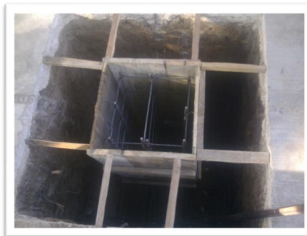
Imagen: 63 Preparación para colocación de válvula compuerta en el Claustro Doctoral.
