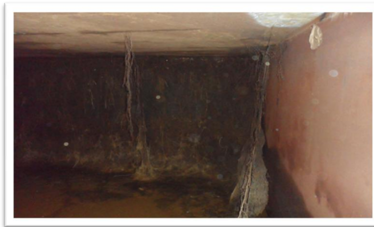
Imagen: 61 Raíces y fisuras de la cisterna general que provocaban filtración.
