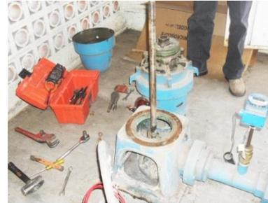
Reparación y embobinado de motor de bomba pozo No. 2.
