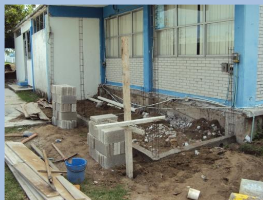
ACONDICIONAMIENTO DE BAÑOS PARA DOCENTES
