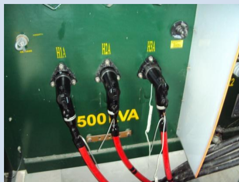
MONTAJE DE TRANSFORMADOR EN SUBESTACIÓN EDIFICIO “Y”
