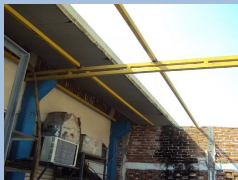
INSTALACIÓN DE LAMINA EN ÁREA DE BUCEO
