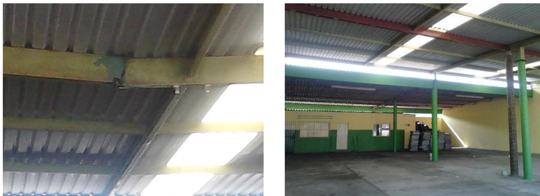
Figura 43. Reparación de la estructura metálica del techo del estacionamiento de autobuses.
